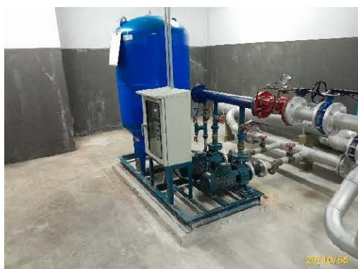
ระบบปั๊มน้ำใช้ชั้นลาดฟ้า
