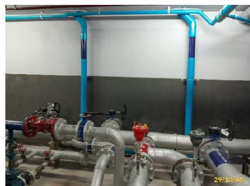
ระบบปั๊มน้ำใช้ชั้นลาดฟ้า
