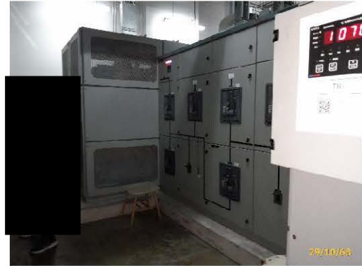
หม้อแปลงไฟฟ้า ขนาด 1,600 KVA จำนวน 2 เครื่อง
